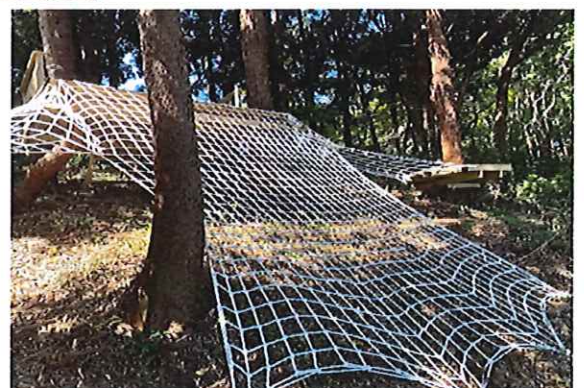
R4.10 ツリーデッキアスレチック完成
