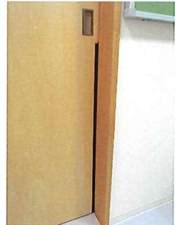
◎引き戸の安全ゴムの設置
