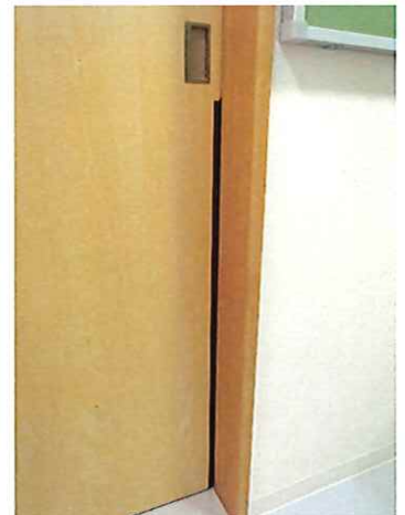
◎引き戸の安全ゴムの設置
